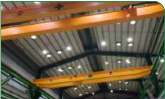
400W~1000W高天井燈水銀壁燈改為150W~240W LED燈
