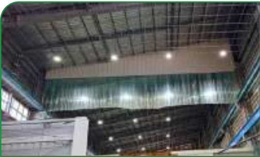
400W~1000W高天井燈水銀壁燈改為150W~240W LED燈
