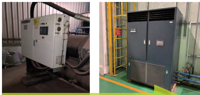
老舊冰水主機汰換成高效節能水冷式箱機
